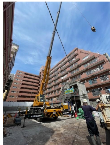
基礎工事に使用したポンプを引きあげるようす。
