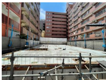
基礎工事が終わり 1階床面工事中
